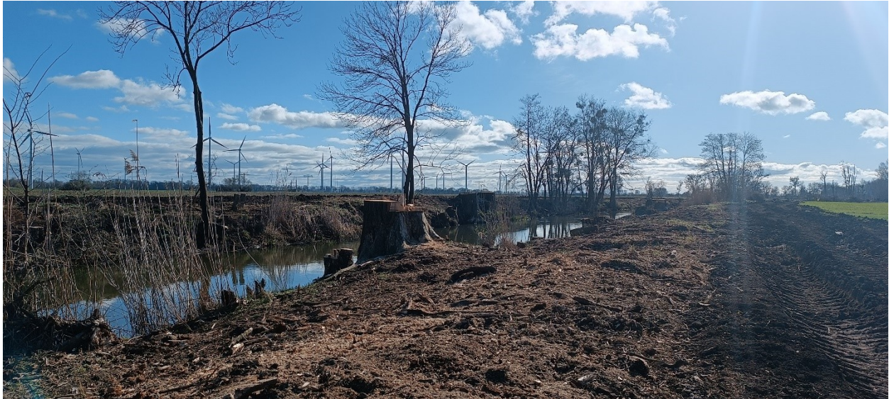
Abnahme der Fällarbeiten im März 2024
