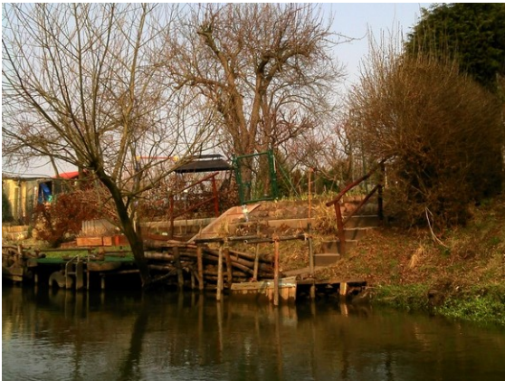
Foto 1: Steg und Uferbefestigung im Uferbereich 0+000 – 1+441
